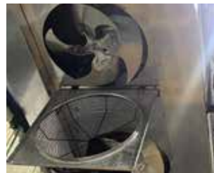
Paneles Venturi para ventilador abatibles para servicio
